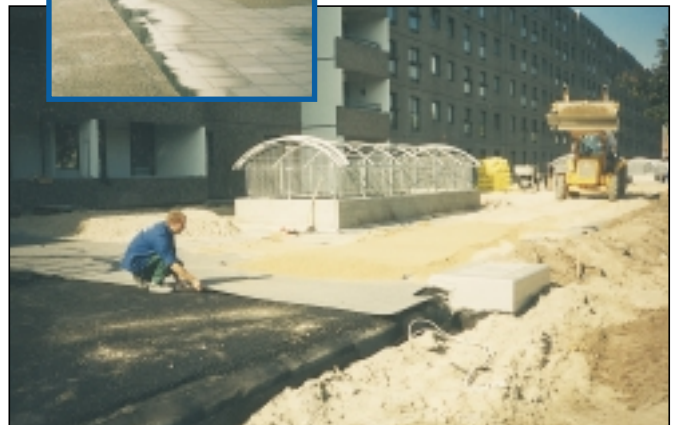
Enkadrain använt i samband med trädgårdsanläggning på parkeringsdäck
