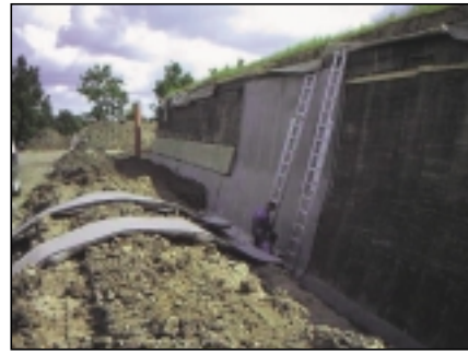
Användning av Enkadrain i samband med vattentank
