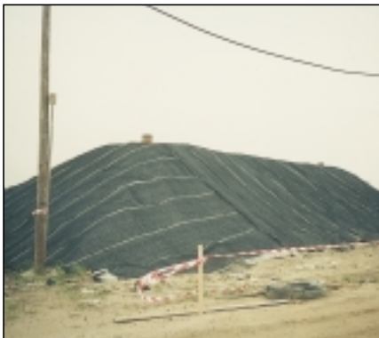
Enkadrain använt som gasdränering i avfallsupplag
