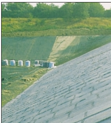
Enkadrain använt i ett avfallsupplag
