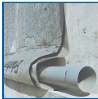
Användning av Enkadrain i samband med källarvägg
