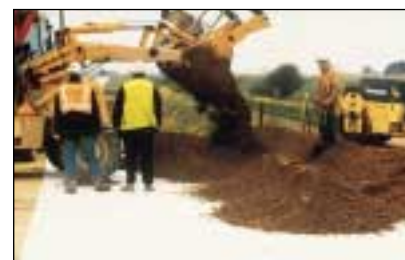
Fyllnadsmaterial läggs på Tensar Basetex.
