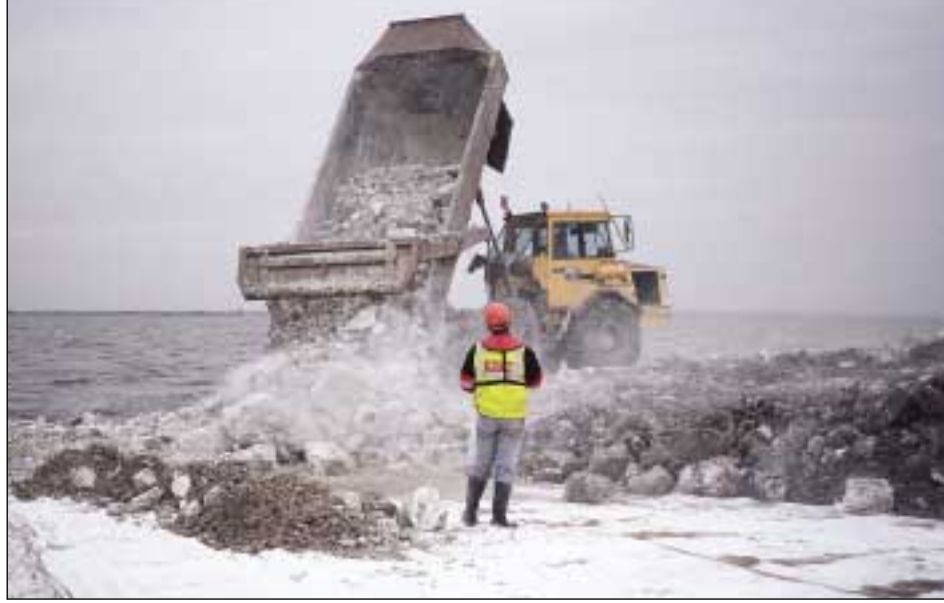
Förstärkning av havsbotten för landåtervinning.
