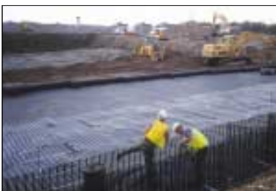
Grundläggning på avfallsdeponi för att kontrollera ojämna sättningar.
