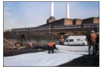
Tensar Basetex klipps till avsedd längd.
