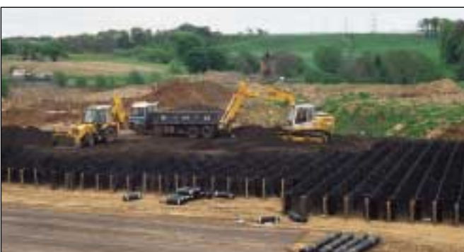
Stabilisering av vägbank för motorväg över deponiområden och löst slam.
