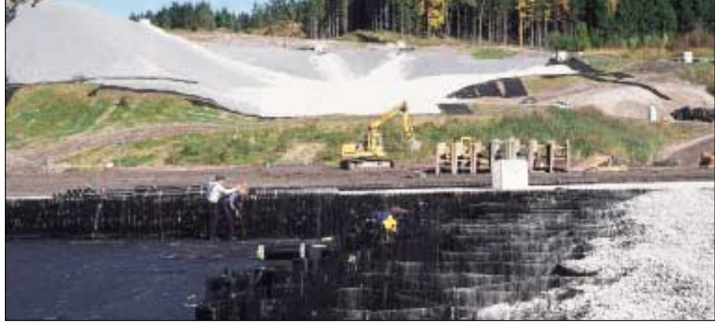
Installation av Tensar Geocell.
