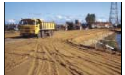
Tensar stabiliserade konstruktionsplattform.
